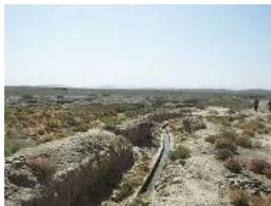
写真－2 (コンクリート補強箇所)
