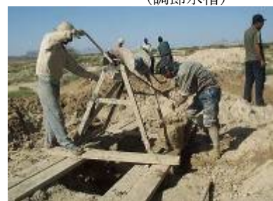
写真－6 (地下に溜まった砂泥を浚渫している状況)
