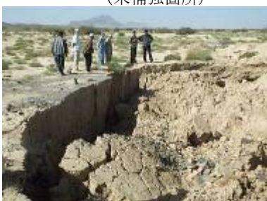
写真－4 (一面が川となって表流水が浸透し、 地下水路が破壊された状況)
